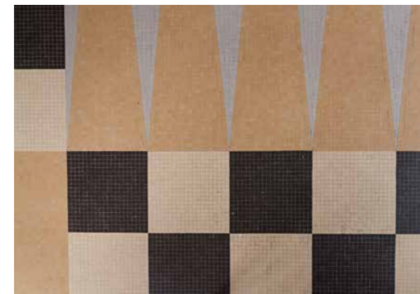
TITO CHINI, DETALLE DEL SUELO EN PIEZAS DE MOSAICO, SALA DE JUEGO, PADIGLIONE DELLE FESTE, TERMAS DE CASTROCARO, 1936-1948
