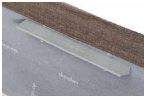
Detalle de los soportes plásticos sobre los que se apoyan las bases rígidas Деталь пластиковых опор, на которых располагаются боковые стороны жестких оснований
