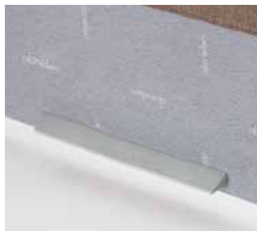
Detalle de los soportes plásticos sobre los que se apoyan las bases rígida Деталь пластиковых опор, на которые кладутся панели дна
